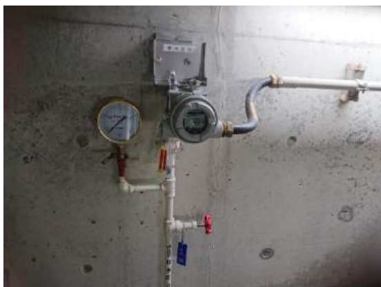
令和6年7月31日 導水施設圧力計更新工事完成(減勢槽)
