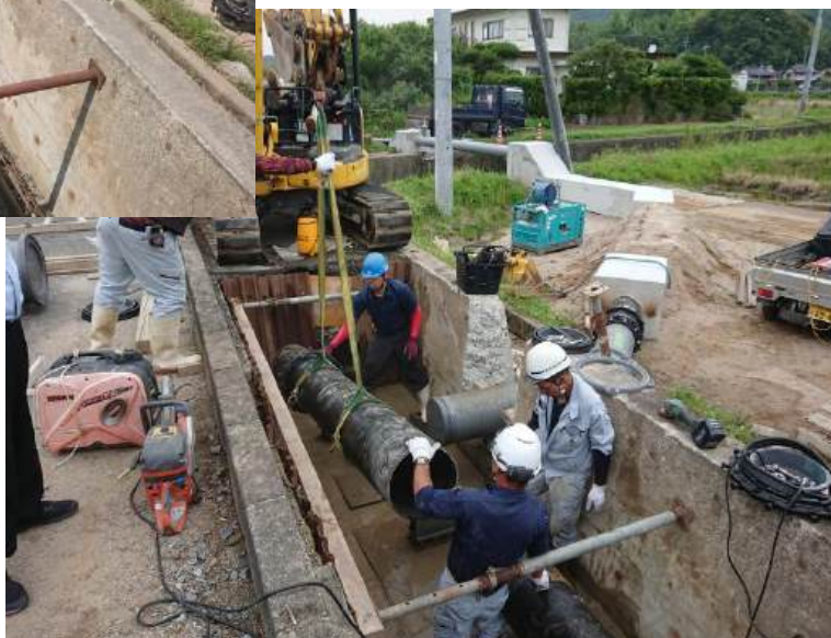
令和7年2月28日 道路改良工事に伴う 田布施・平生線送水管移設工事完成
