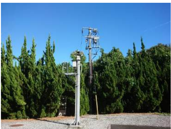
令和6年10月31日 第一調整池高圧気中開閉器及び高圧ケーブル更新完了
