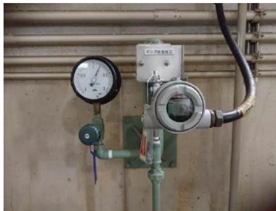
令和6年7月31日 導水施設圧力計更新工事完成(第一調整池)
