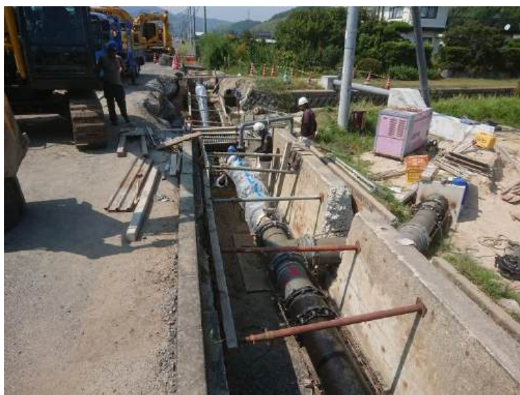
令和7年2月28日 道路改良工事に伴う 田布施・平生線送水管移設工事完成
