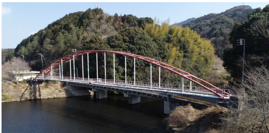
写真 9 送水管の水管橋
