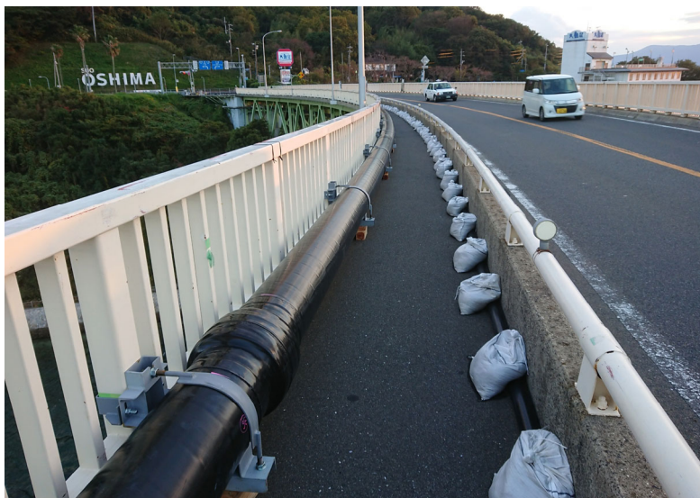
写真 8 大島大橋の仮設送水管による送水再開（平成 30 年 11 月 29 日）
